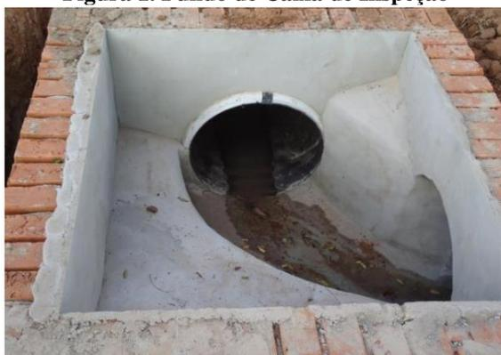
**Figura 2. Fundo de Caixa de Inspeção**
